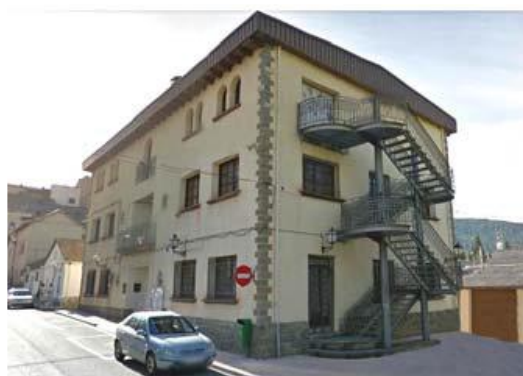
Imagen 26. Imagen del edificio Centro Sociocultural Puente Sardas
