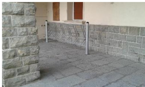
Imagen 56. Vista del aparcamiento de bicicletas instalado en Pza. España
