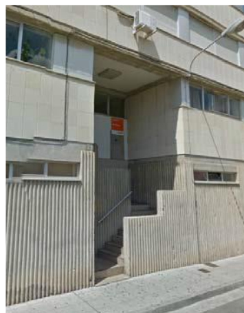
Imagen 22. Entrada a las instalaciones de la Casa de Cultura A. Durán Gudiol
