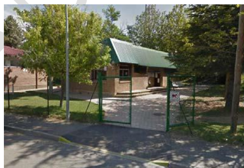
Imagen 41. Zona de acceso a las instalaciones
