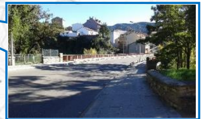
Puente sobre el Río Gállego
