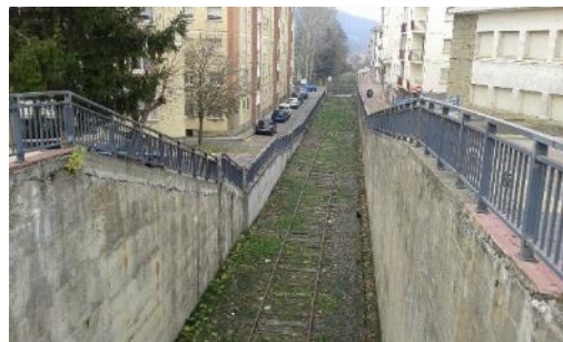
Imagen 3. Ramal ferroviario de la fábrica Ercros
